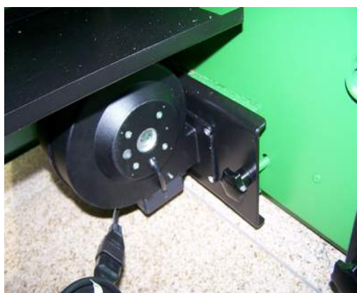
Czyszczenie komory pod paleniskiem.
