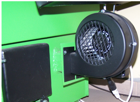
Montaż i podłączenie nadmuchu
