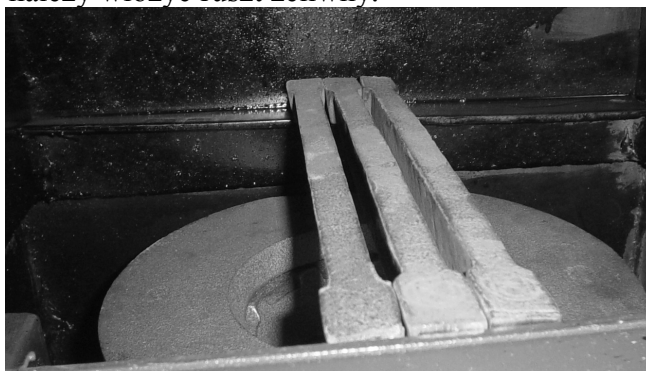
Układanie rusztu żeliwnego
