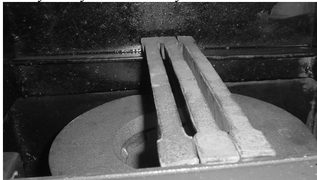
Układanie rusztu żeliwnego
